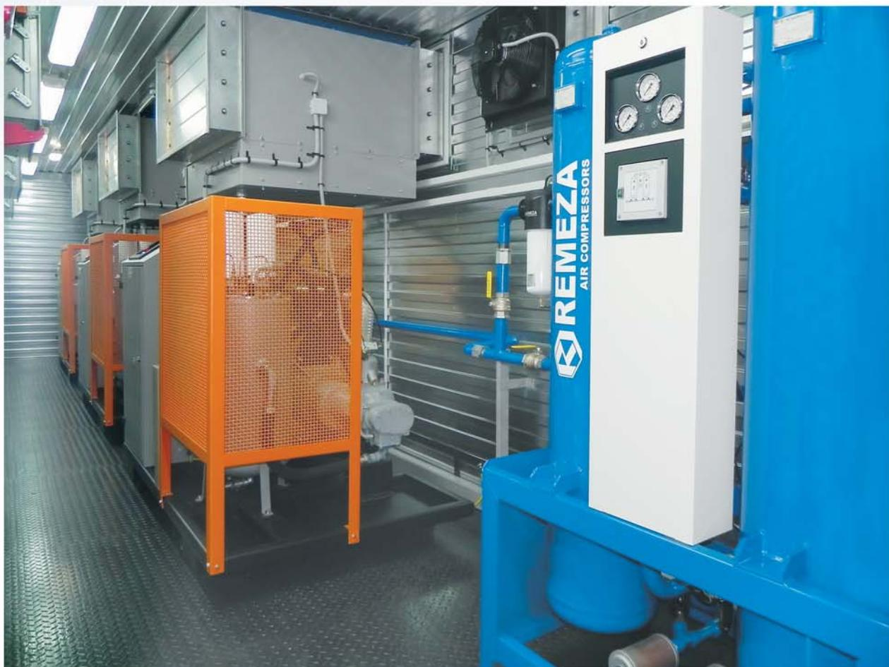
Применение модульных компрессорных станций, выполненных на базе 20-ти и 40-ка футовых железно-дорожных контейнеров морского исполнения, по сравнению со станциями расположенными в капитальных зданиях, дает значительную экономию средств и времени, исключая затраты на строительство. По сравнению со станциями выполненными на базе кунгов – наиболее полное обеспечение оборудованием, повышенная безопасность и высокая степень автоматизации в управлении.
